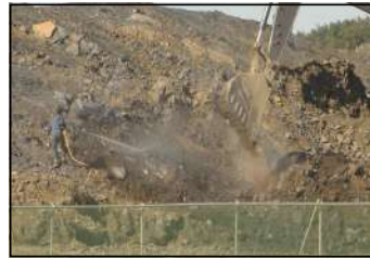
[세륜·측면살수시설 설치] [차량속도 제한표지판 설치] [토공사시 살수 실시]
