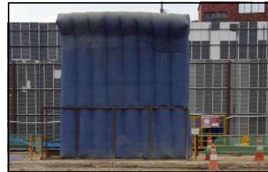
[이동식 방음벽 설치]
