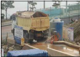
[세륜·측면살수시설 설치] [차량속도 제한표지판 설치] [토공사시 살수 실시]
