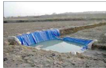
[임시침사지검 저류지 설치]
