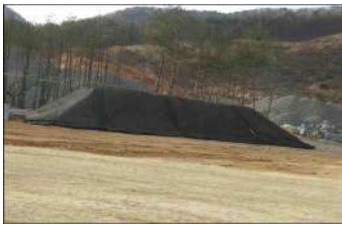
[토사 적치시 덮개 설치]
