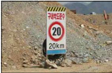
[차량속도 제한표지판 설치]
