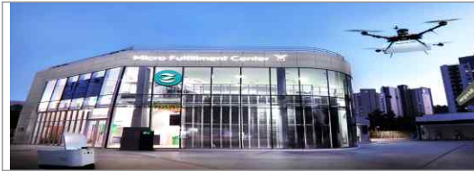
주문배송시설과 결합된 GS칼텍스 내곡주유소('23 준공)
